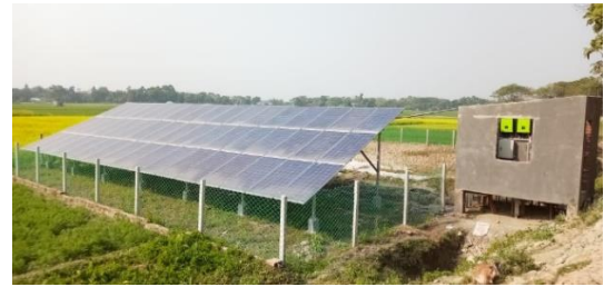
চিত্র ৩ঃ প্রকল্পে স্থাপিত ১৫.৮১(১০.৫৪+৫.২৭) কিঃ ওঃ সোলার প্যানেল
