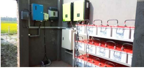
চিত্র-৪ঃ প্রকল্পে স্থাপিত ৫ কিঃ ওঃ মাইক্রো গ্রিড এর ইনভার্টার ও ব্যাটারি
