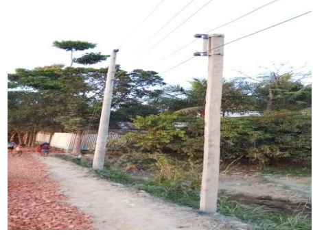
চিত্র ৫ঃ প্রকল্পে স্থাপিত প্রকল্পে স্থাপিত ৫ কিঃ ওঃ মাইক্রো গ্রিড এর সিঙ্গেল ফেজ লাইন
